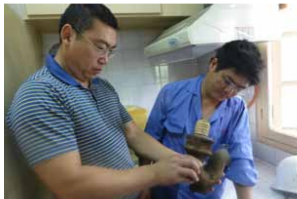
程兵的正能量服务队为居民义务维修水管
